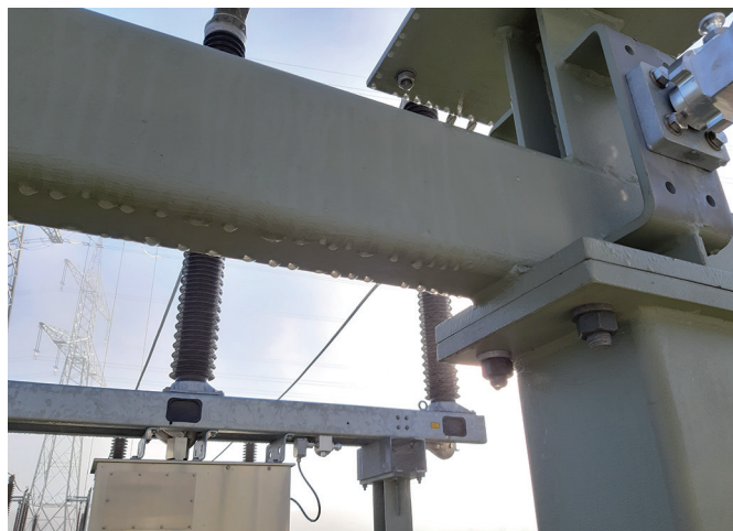
Bild 3 Nebel und Tau- eigentlich schlechte Bedingungen für Beschichtungsarbeiten
